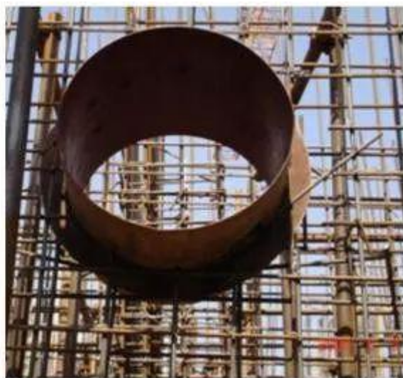
通风预埋管预埋应设洞口加强筋
