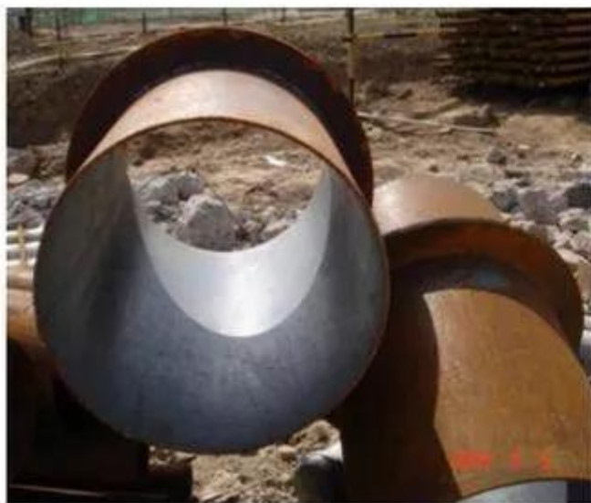
预埋管翼环宽度 \geq 50\text{mm} 、板材厚 \geq 3\text{mm}
